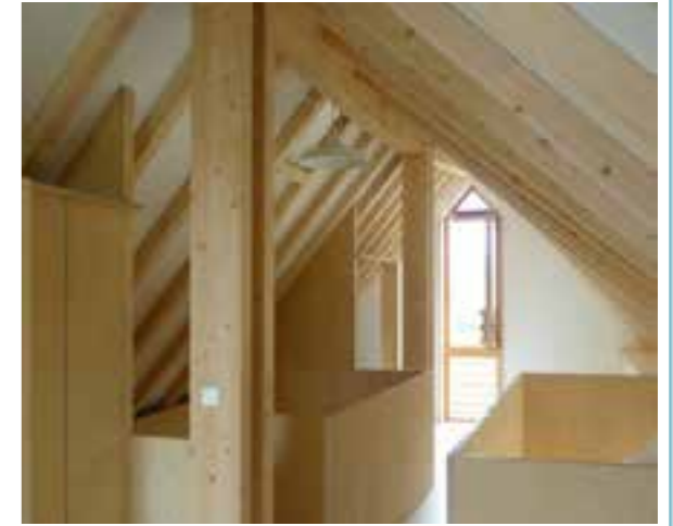
Structure en sapin Maison individuelle (15) - ©P. Gourvenec - Arba Architectes
