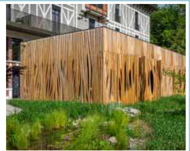
Revêtement extérieur en châtaignier - Maison Aribert (38) ©David Richalet - Joëlle Personnaz Architecte
