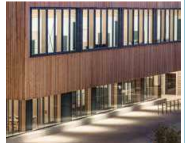
Parement extérieur en mélèze - Groupe Scolaire d'Alex (74) ©Luc Boegly - Nunc Architectes - L'Atelier des Cairns
